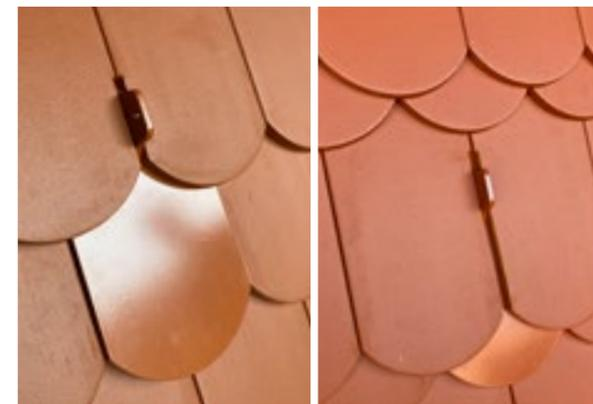
(Bild 2, links Doppeldeckung, rechts Kronendeckung)
