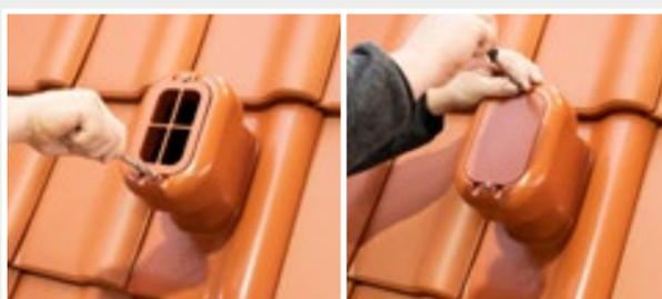
Zur Vorbereitung der Installation bauen Sie bitte den Sanitärlüfter ohne Flexschlauch an die vorgesehene Stelle ein.
