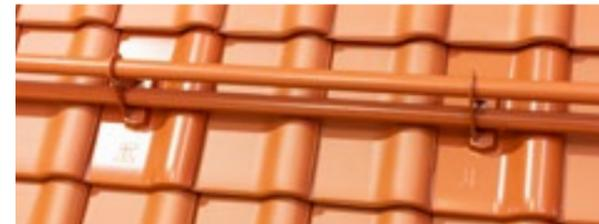
Bevor die Doppelrohrhalterung auf die Grundpfanne montiert werden kann, muss die aufgeschraubte Mutter mit einem 13-mm-Schraubenschlüssel gelöst werden.
