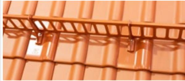
Bevor das Schneefanggitter auf die Grundpfanne montiert werden kann, muss die aufgeschraubte Mutter mit einem 13-mm-Schraubenschlüssel gelöst werden.
