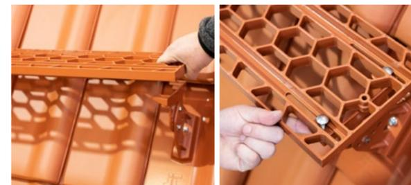
Bevor die Kurz-/Langrosthalterung auf die Grundpfanne montiert werden kann, muss die aufgeschraubte Mutter mit einem 13-mm-Schraubenschlüssel gelöst werden.
