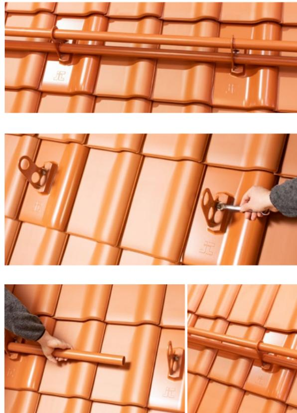
Bevor die Doppelrohrhalterung auf die Grundpfanne montiert werden kann, muss die aufgeschraubte Mutter mit einem 13-mm-Schraubenschlüssel gelöst werden.
