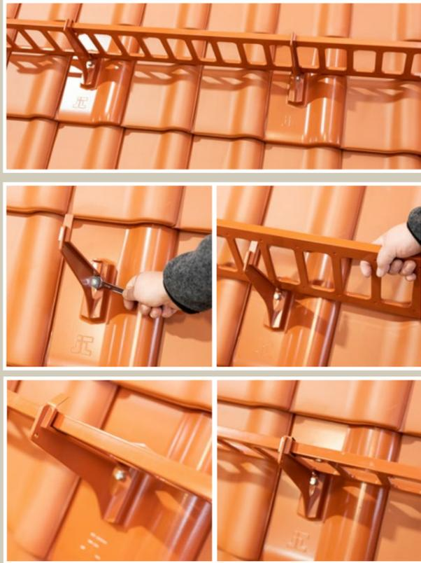
Bevor das Schneefanggitter auf die Grundpfanne montiert werden kann, muss die aufgeschraubte Mutter mit einem 13-mm-Schraubenschlüssel gelöst werden.
